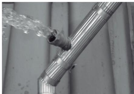
Nos sistemas bombeados, abra o eliminador de ar com a bomba em funcionamento, deixe varzar por 1 minuto aproximadamente e volte a fechá-lo com a bomba ainda em funcionamento.
