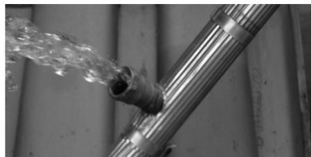
Nos sistemas bombeados, abra o eliminador de ar com a bomba em funcionamento, deixe varzar por 1 minuto aproximadamente e volte a fechá-lo com a bomba ainda em funcionamento.
